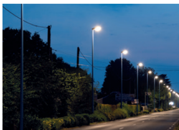
Après travaux de rénovation de l'éclairage public.
