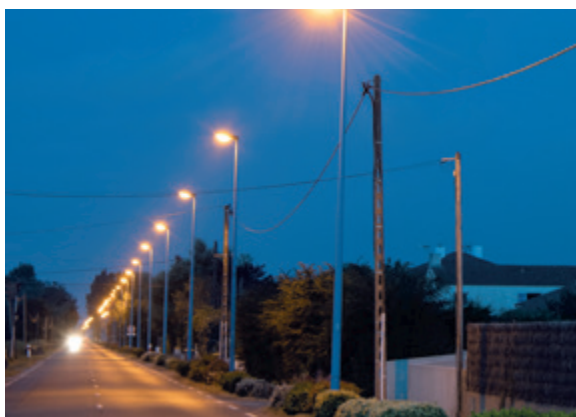
Avant travaux de rénovation de l'éclairage public.
