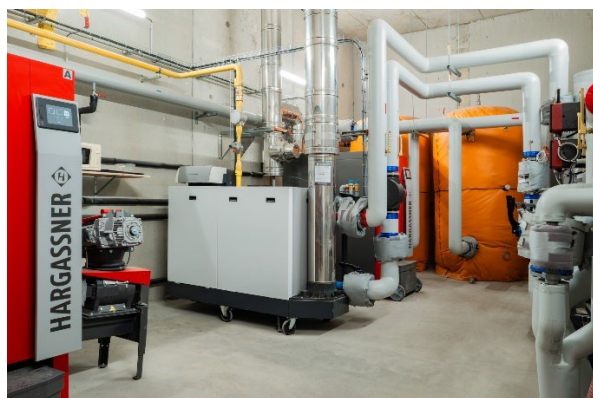
La chaufferie bois de Treize-Septiers alimente 4 bâtiments avec un réseau de chaleur ©SYDEV-Pierre Ollier
