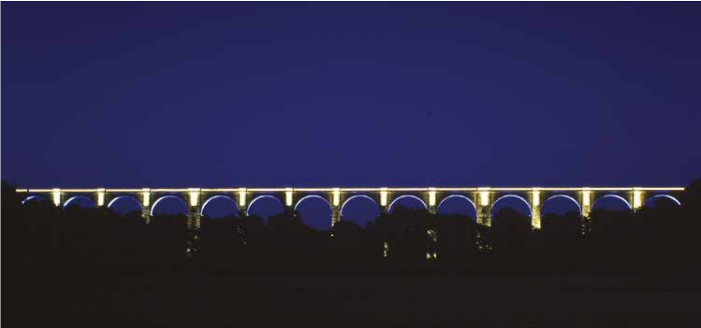
Le viaduc de Barbin à Saint-Laurent-sur-Sèvre, mis en lumière en 2005.
