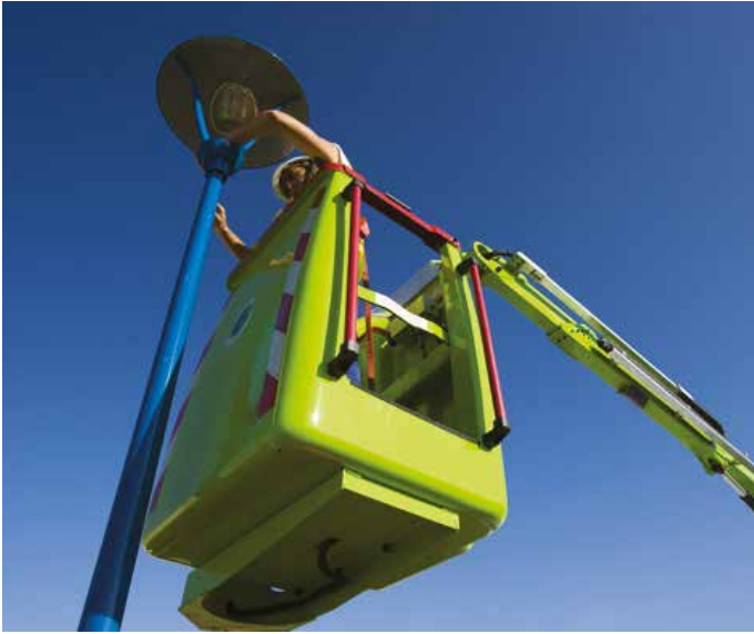
Opération de remplacement de luminaires ou relamping.
