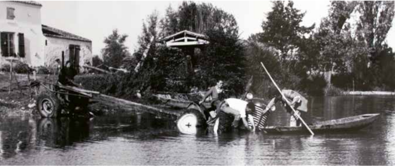
Dans le marais, l'ingéniosité est de mise pour transporter les poteaux.
