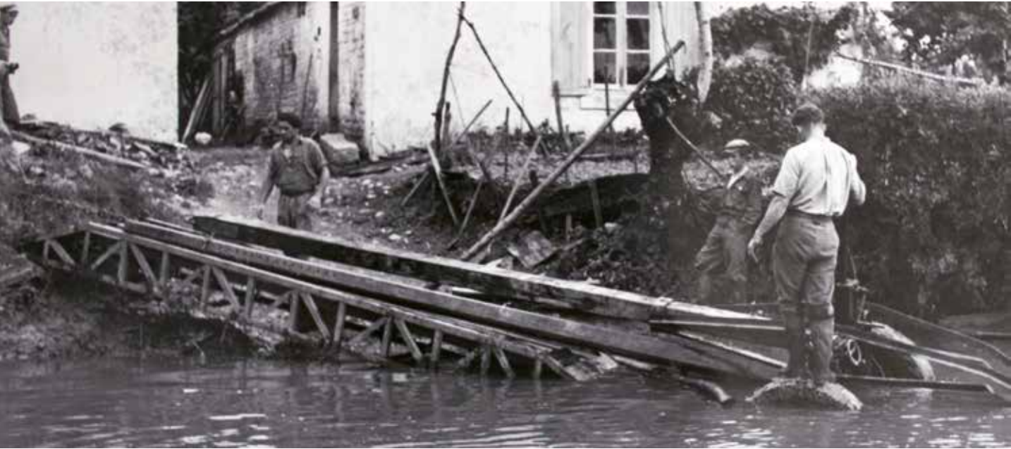
Malgré les difficultés comme ici dans le marais, l'installation des poteaux se poursuit.
