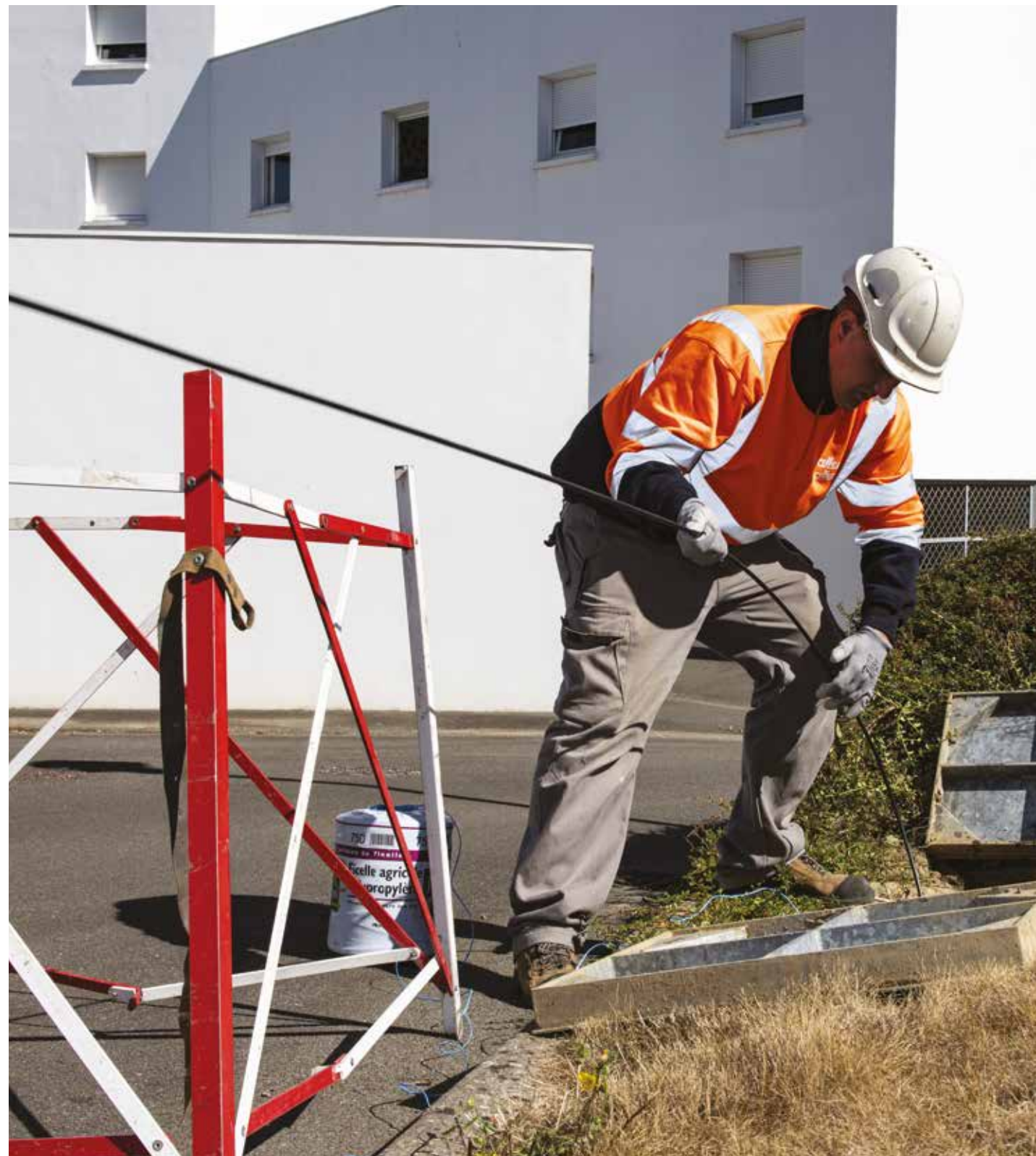
Installation de la fibre à Saint-Gilles-Croix-de-Vie.
