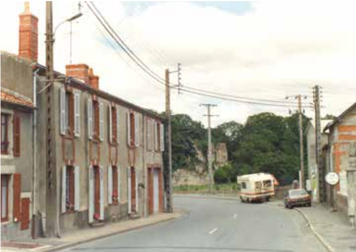
Les Essarts avant effacement des réseaux électriques...
