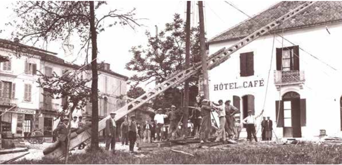
Levage d'un poteau béton - Entreprise Allez 1950.
