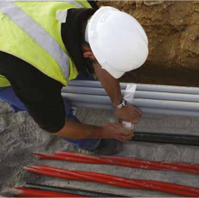
Une première en France : le SyDEV et France Télécom coordonnent leurs travaux d'effacement.
