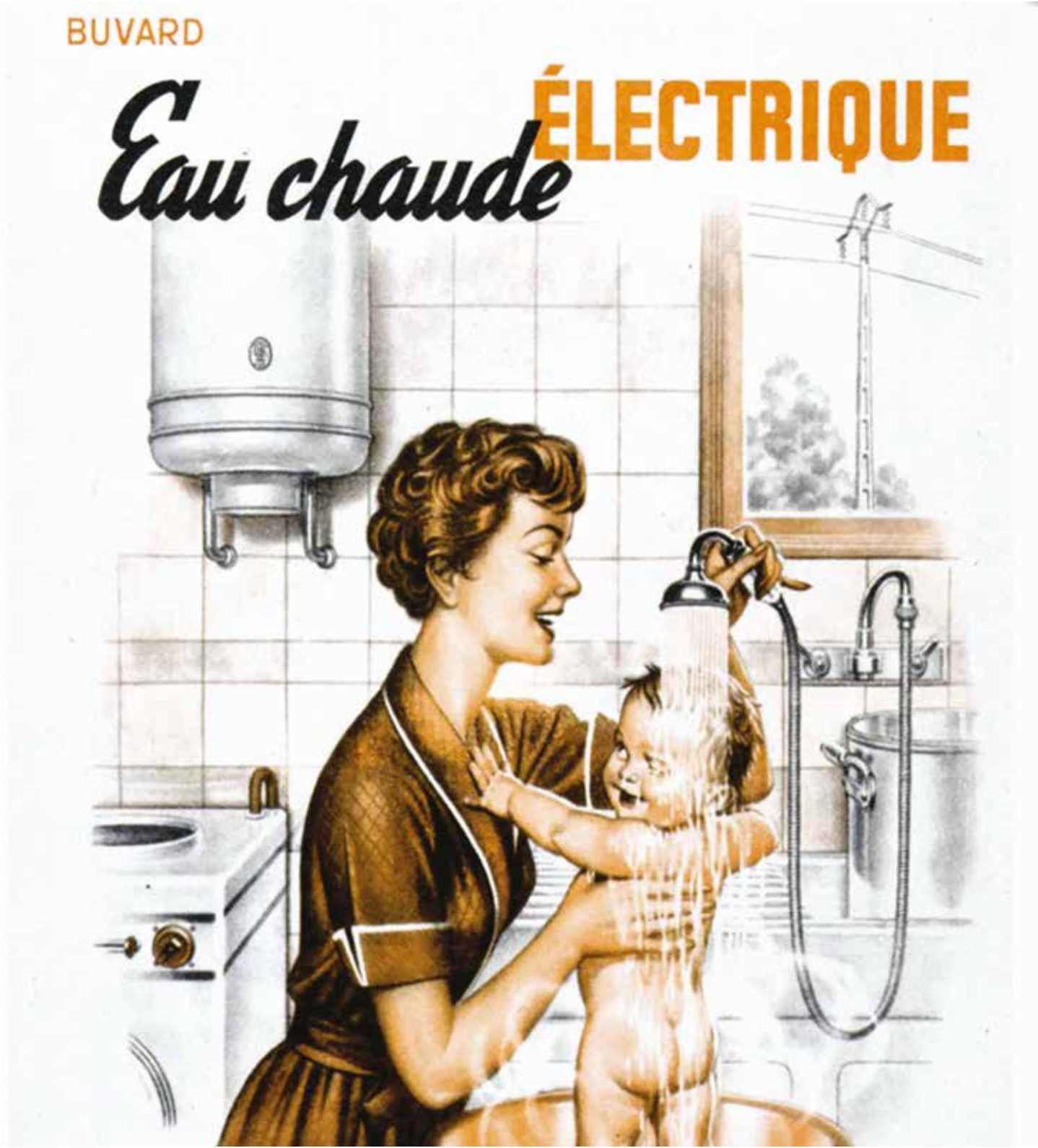
Le confort électrique entre dans les foyers français.
