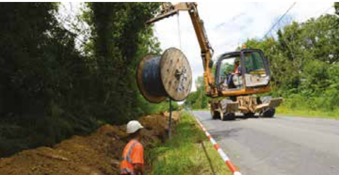
Travaux d'effacement de réseaux comme ici au Champ-Saint-Père.
