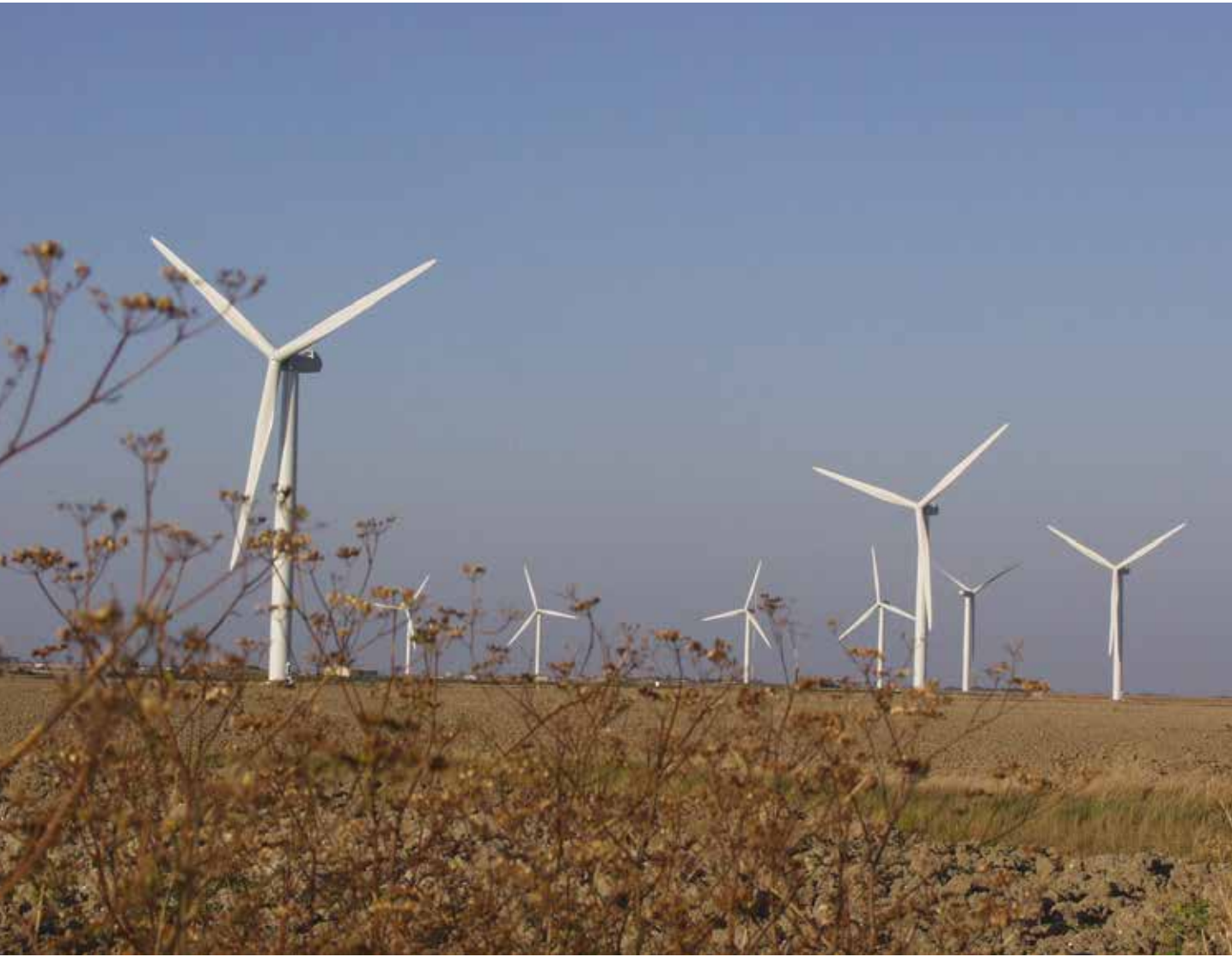
Les huit éoliennes du parc de Bouin, dont trois détenues par Vendée Énergie.
