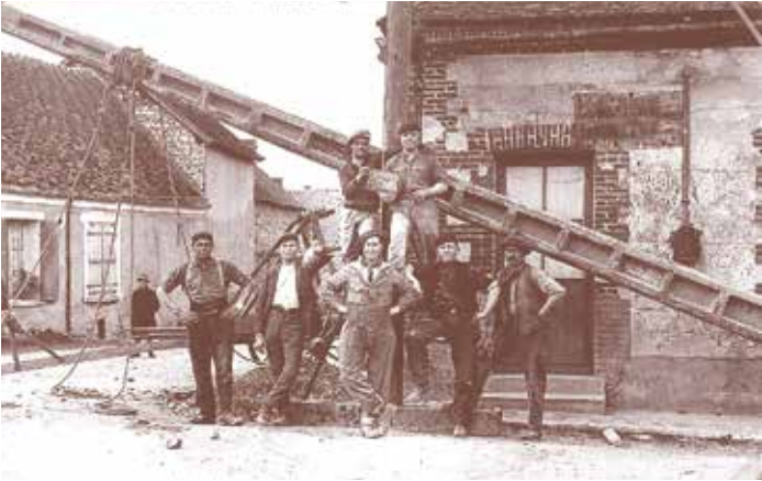
Les poteaux béton apparaissent dans le paysage vendéen.
