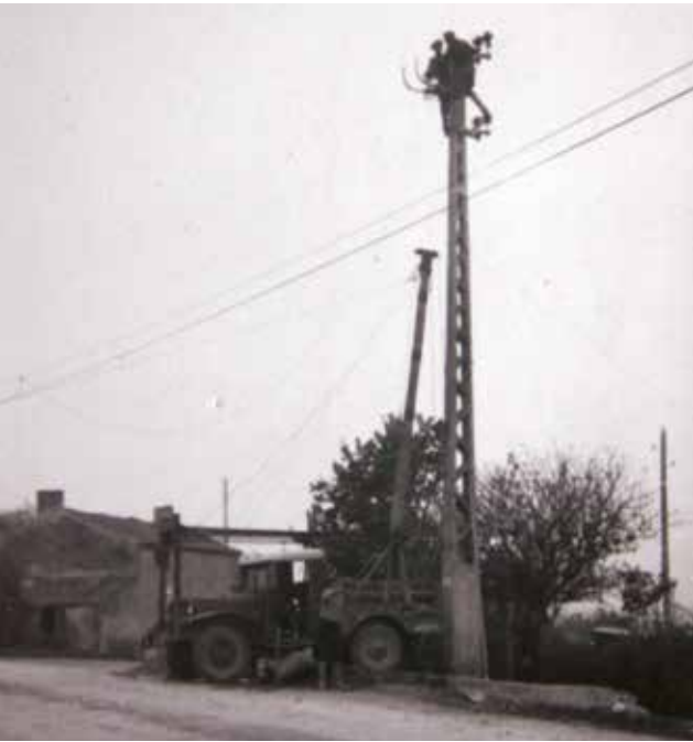
Mise en place des fils électriques sur poteau.
