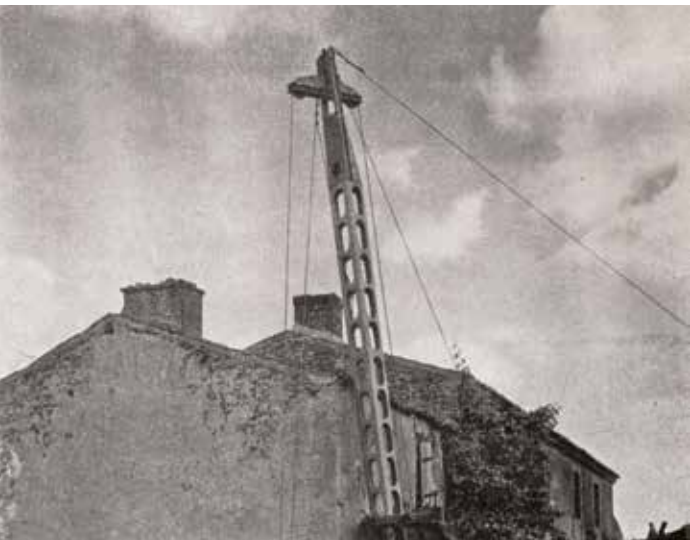
L'électricité arrive, les poteaux sont érigés.
