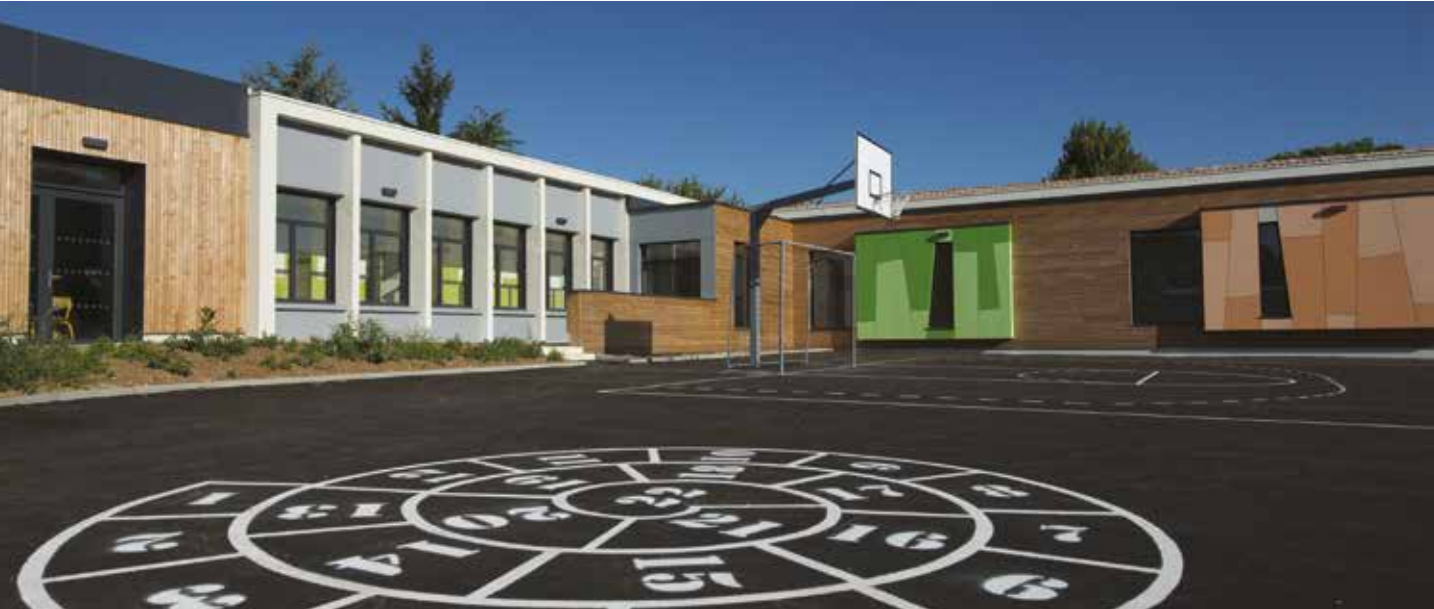
Rénovation énergétique de l'école à Nieul-sur-l'Autise.
