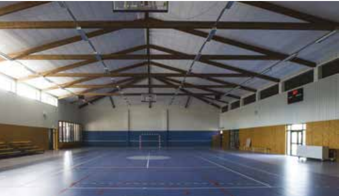
Rénovation énergétique de la salle de sport à Mouilleron-Saint-Germain.
