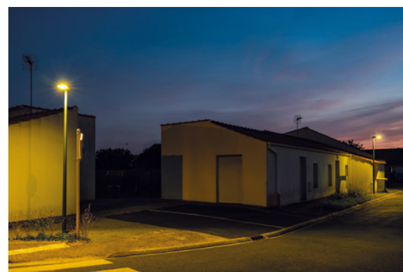
Après travaux de rénovation de l'éclairage public.
